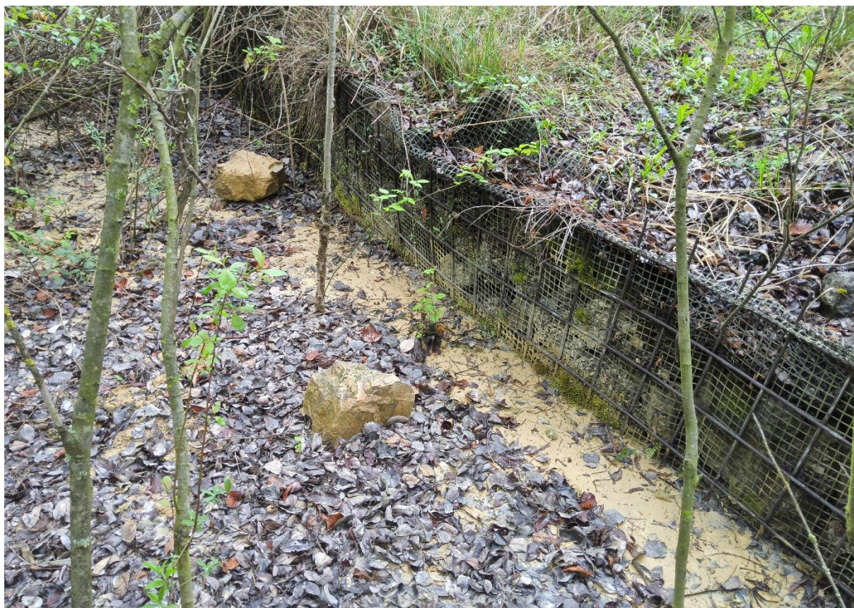
Dettaglio del rilevato e del vallo, con alcuni blocchi in evidenza e la presenza di fango e ristagno idrico.
